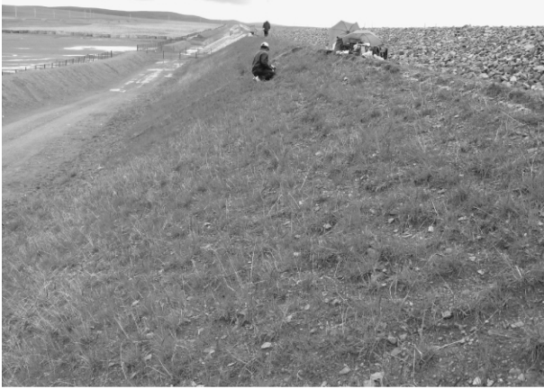
图 3 路基边坡阳坡试验区
